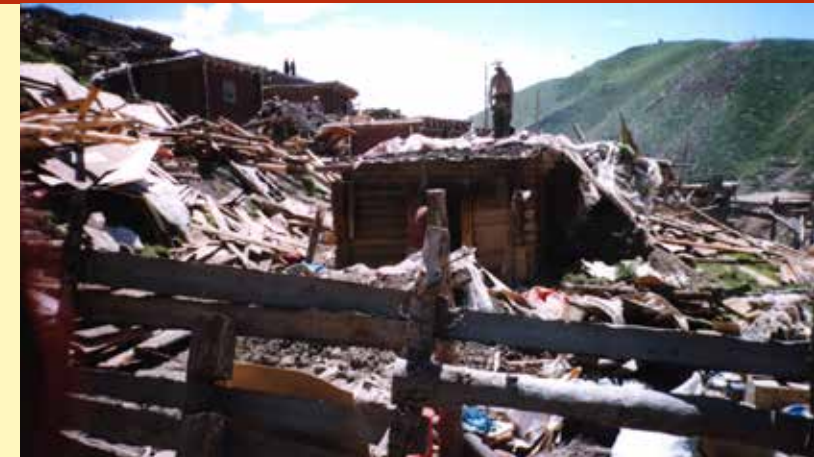
De puinhopen ná de sloop
